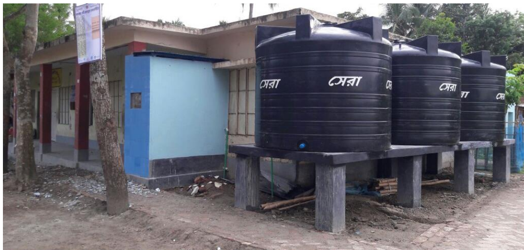
Abbildung 3 Regenwasserspeichersystem nach Fertigstellung
