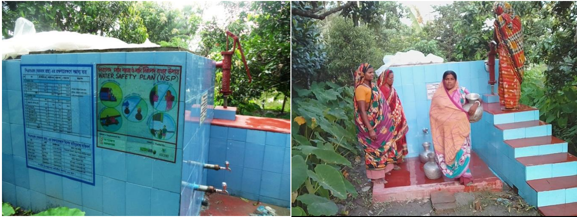
Abbildung 5 Sandfilter 4 nach Fertigstellung
