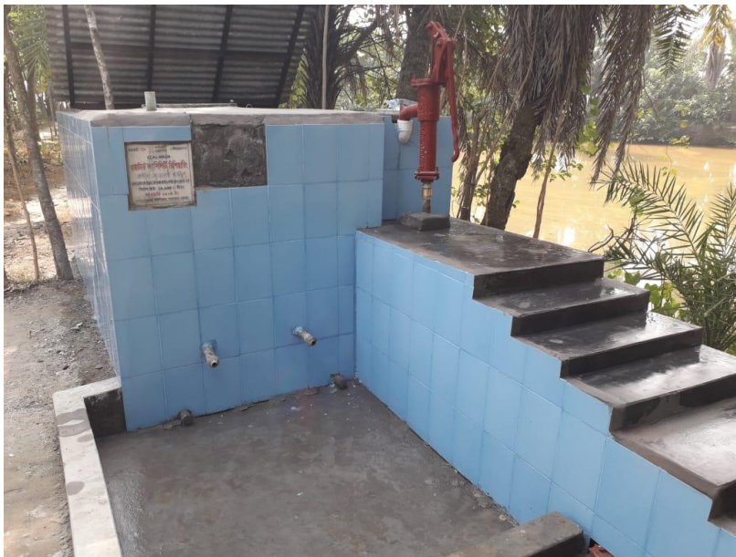
Abbildung 8 Sandfilter 7 nach Fertigstellung
