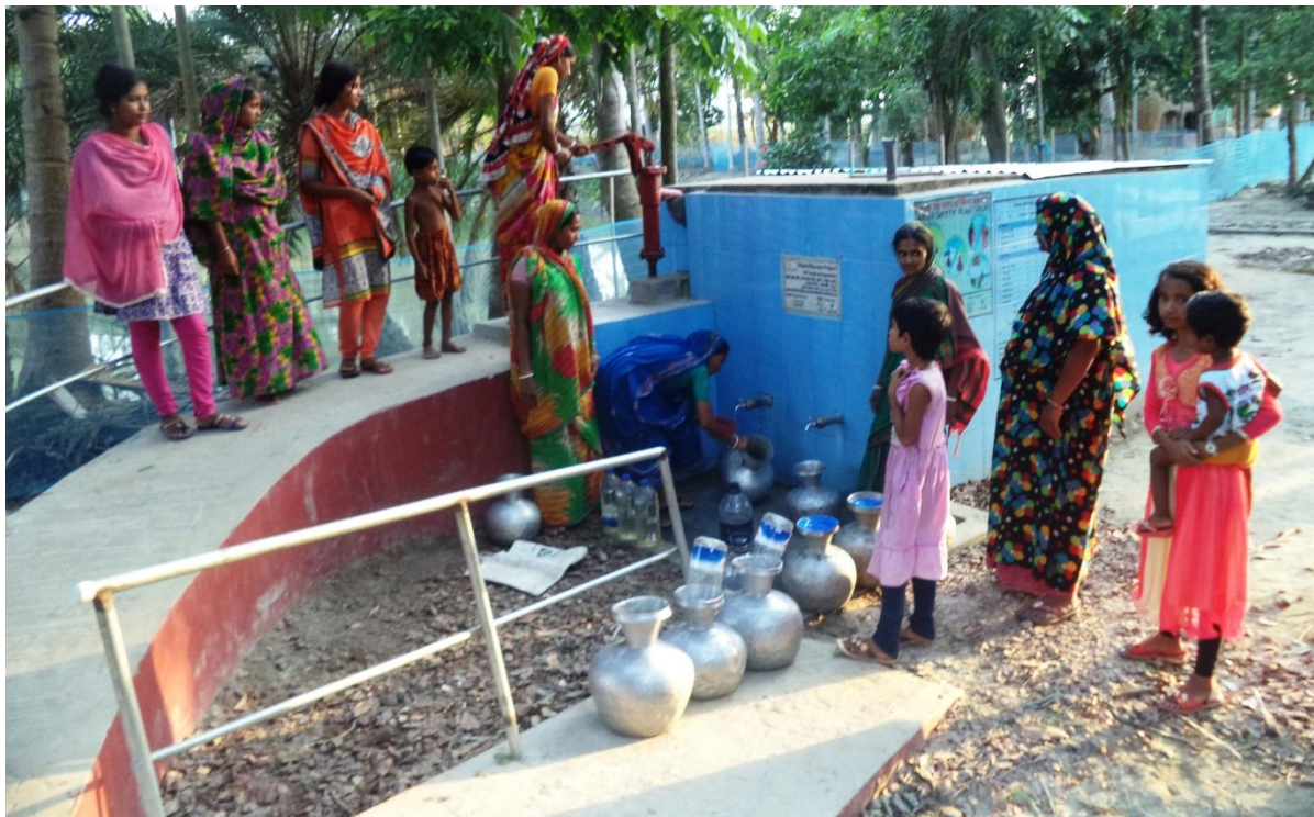
Abbildung 1 Sandfilter 1 nach Fertigstellung
