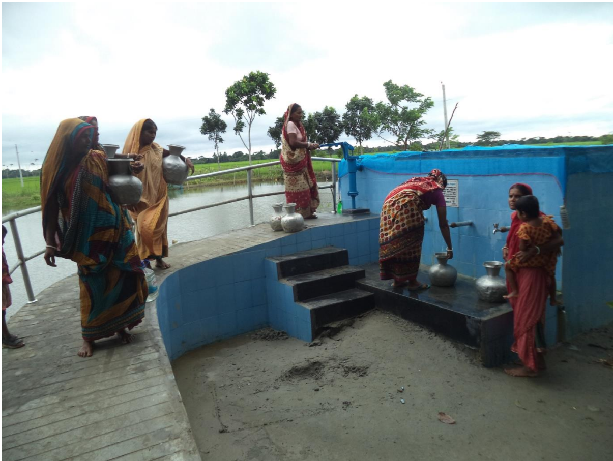
Abbildung 6 Sandfilter 5 (Neuinstallation) nach Fertigstellung
