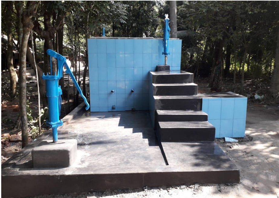
Abbildung 7 Sandfilter 6 nach Fertigstellung
