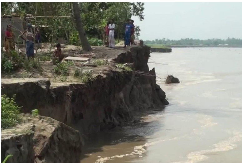
Flussufererosion in Dacope
